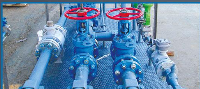
ОБВЯЗКА БЛОКА ПРОБКОУЛОВИТЕЛЯ
